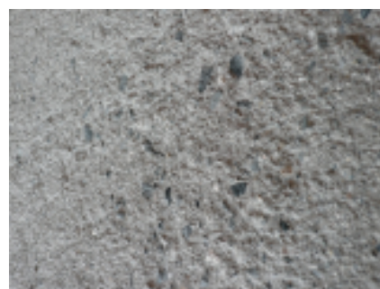
図-2 チップング後のコンクリート表面
