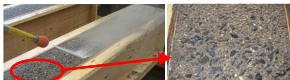
写真-1 打継目処理の一例
