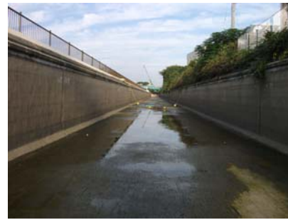
図-12 コンクリート開水路の状況
