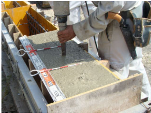
写真-1 バイブレータ挿入時
