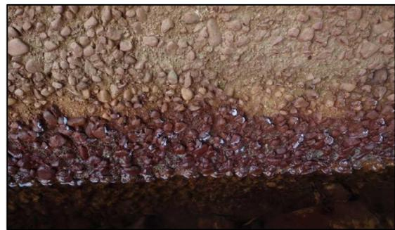
写真-1 酸性河川に位置する橋脚の劣化事例が同時に作用していることが多い<sup>5)</sup>。
