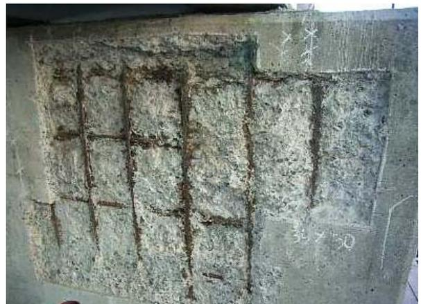
写真-1 鉄筋の腐食
