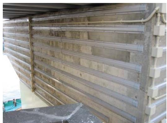
写真-4 P7の電気防食装置
