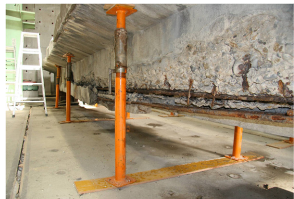
図－６ 外桁の外観（実験室搬入後）
