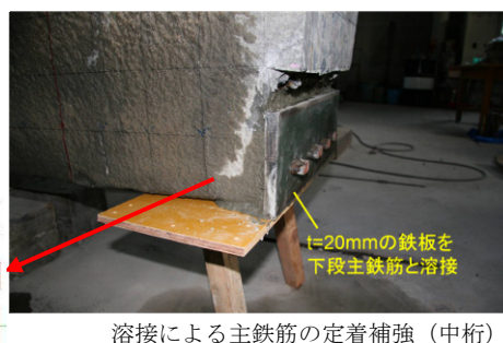
溶接による主鉄筋の定着補強（中桁）
