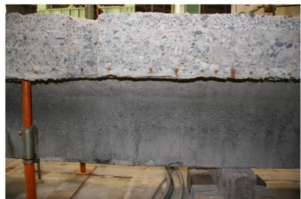
図－７ 中桁の外観（実験室搬入後）
