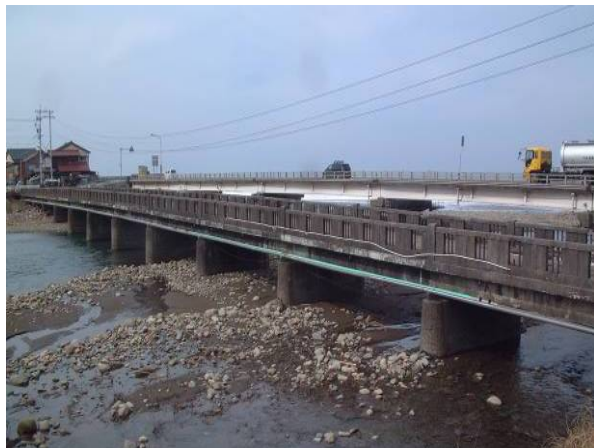
図-1 能生川橋の外観（平成 20 年 8 月撮影）
