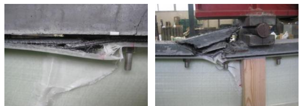
(1) HFRP 界面剥離 (2) UFC 圧縮破壊
