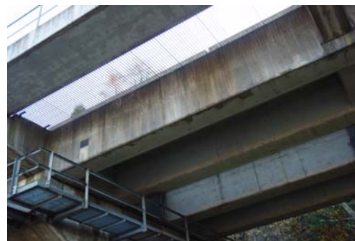
写真-1 開床式鉄道高架橋
