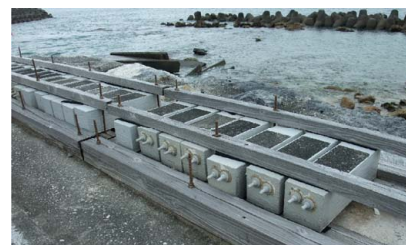
写真-1 試験体の暴露状況
