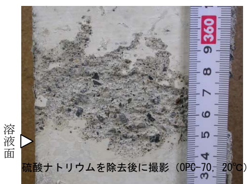
写真-3 スケーリング部分の外観の一例
