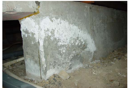
写真-1 住宅基礎コンクリートの劣化状況（一例）
