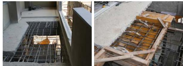
(a) 既存床スラブ削り後 (b) 新設床スラブ打設前
