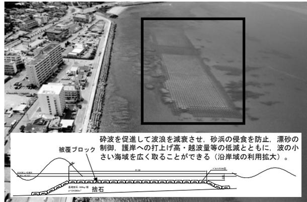
写真-1 海岸構造物の例 (人工リーフ)
