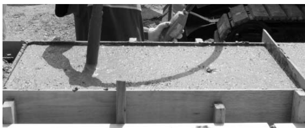
写真-2 バイブレータによる振動締固め
