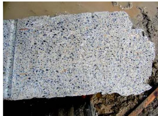
写真-3 杭先端の断面(杭 4)
