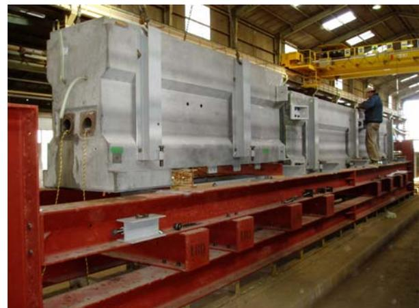
写真-3 プレキャスト・セグメントの架設・接合
