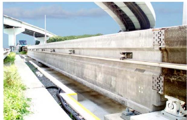
写真-1 桁長 40m の跨座型モノレール軌道桁
