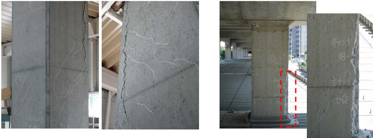
(a) 4 隅の軸方向鉄筋に沿った鉛直ひび割れ
