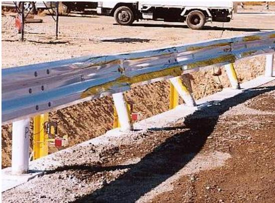
写真-4 擁壁天端防護柵の変形状況
