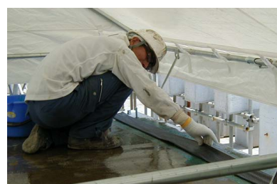
(3) CFシート貼り付け
