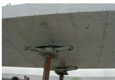
(1) ジャッキアップ
