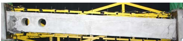
写真-1 全体変形状況 (F-1,R=1/10時)
