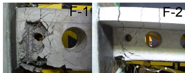
写真-2 開口部周辺の損傷状況 (R=1/10時)
