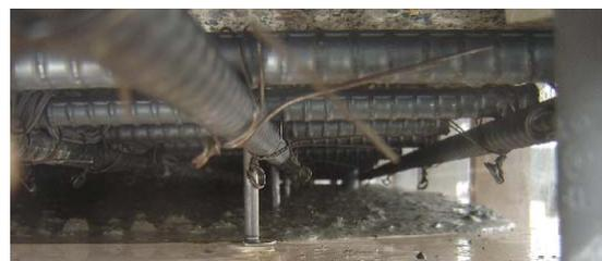
図-10 型枠内部での耐硫酸コンクリートの流動状況
