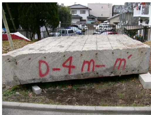
図-4 コンクリートアーチ道路橋アーチ部材
