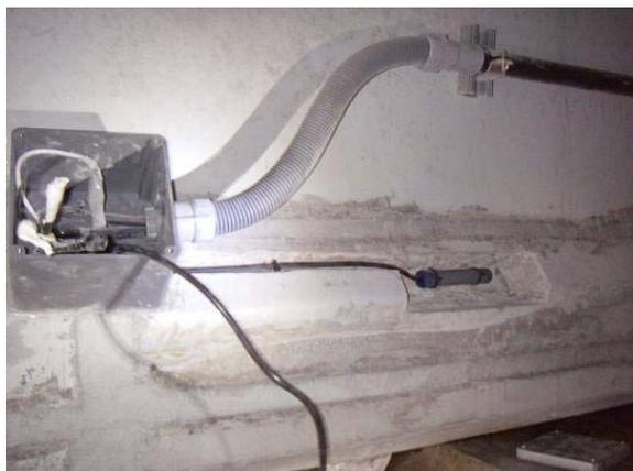
写真-2 照合電極の取替え状況
