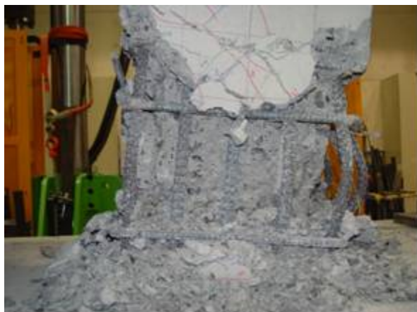
写真－３ 16 \delta_y 載荷時点の損傷状況
