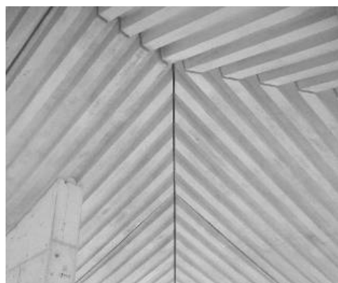
写真－４ 寄棟天井素地仕上げ
