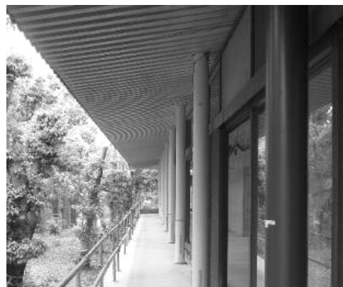
写真－３ 軒先天井素地仕上げ
