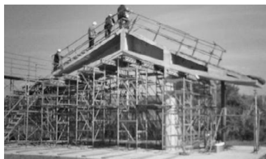
写真-2 実大施工実験状況
