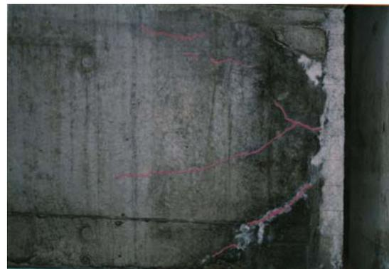
写真-3 D橋桁端部のひび割れ
