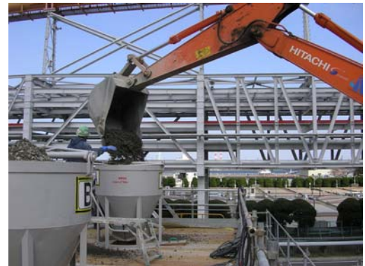
写真—3 解体コンクリート塊の計量
