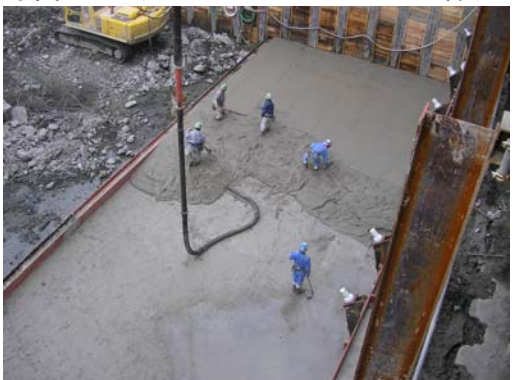
写真—5 ラップルコンクリートの打込み
