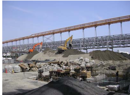
写真—2 解体コンクリート塊の保管状況
