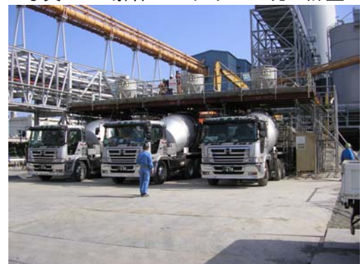
写真—4 ラップルコンクリートの練混ぜ
