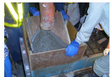
写真-4 ランク 1 打込み状況
