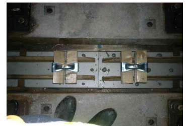
写真-5 スラブ充てん確認
