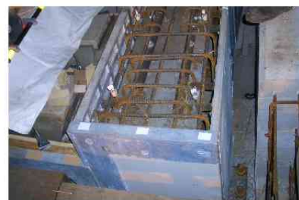
写真 - 1 ひび割れ防止鉄筋の設置状況
