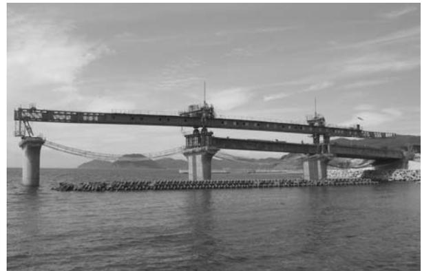
写真-1 主桁架設状況
