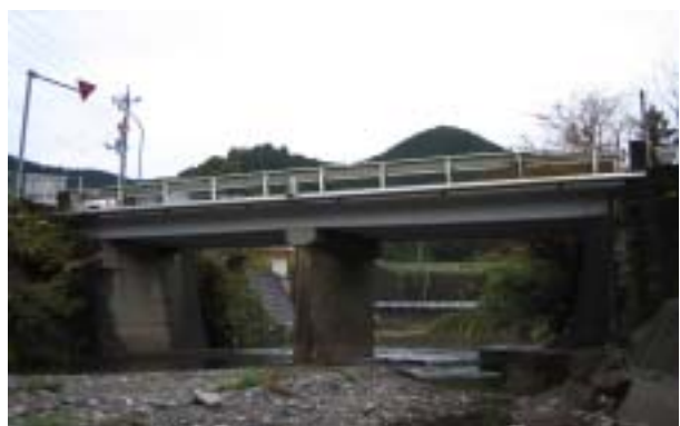
写真 - 1 点検調査対象橋梁全景（一例）
