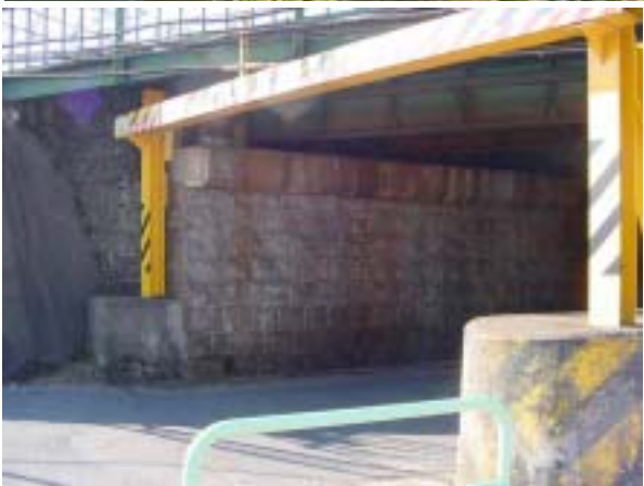
写真-1 管内の石レンガ積み橋脚
