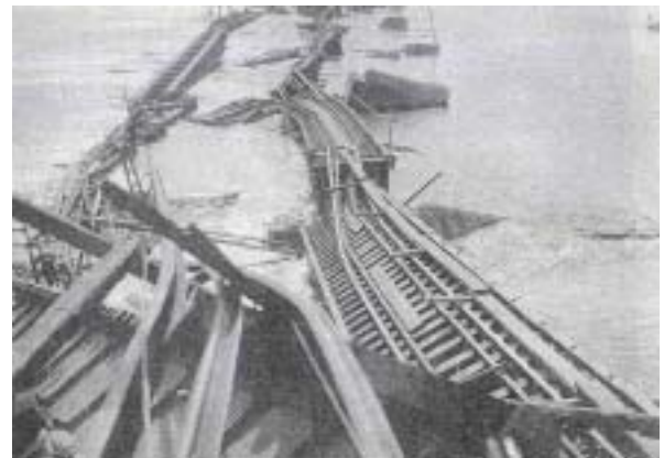
写真-4 転倒・崩壊 3)
