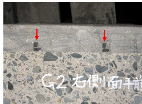
(b) 試験体 G2；柱基部から 1,200 mm 付近
