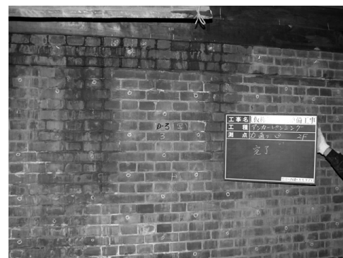
図-2 ステンレスピン挿入後
