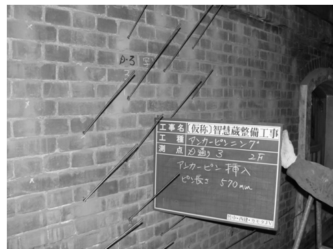
図-1 ステンレスピン挿入時
