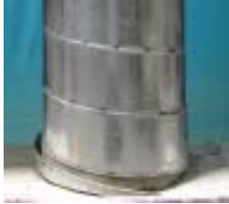
CR2-2 スポット溶接破断
