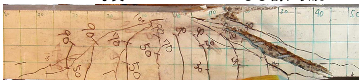
写真－６ NSLG-40-B ひび割れ状況
