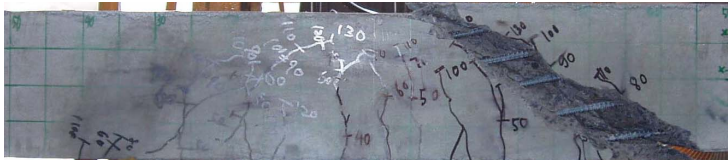
写真－４ LSN-40-B ひび割れ状況
