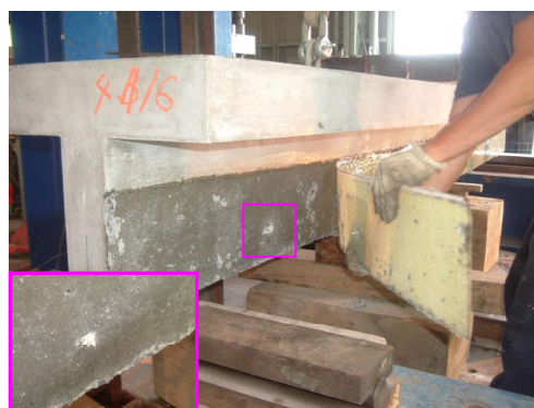
写真-4 アンカー破断状況
