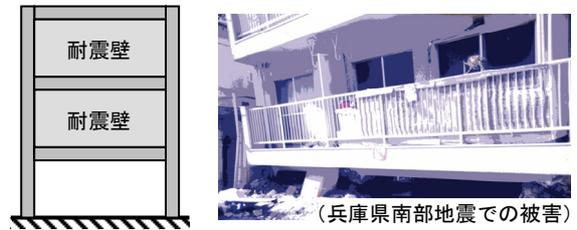
図-1 下階壁抜け柱 写真-1 下階壁抜け柱の被害
