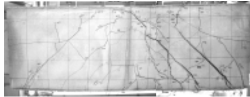
No.2 既設軸方向鉄筋破断直前
