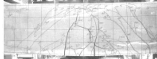
No.5 既設軸方向鉄筋破断直前
