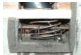
写真-2 スパイラル筋
