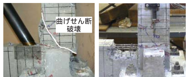
写真 - 4 実験終了後の柱脚の破壊状況
