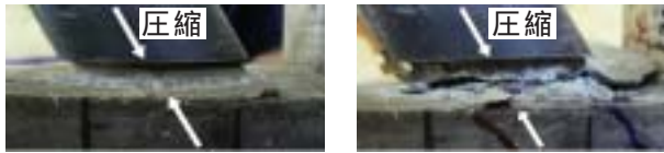
(a) - 3サイクル (b) 最終 - 11サイクル 写真 - 6 プレースの基礎梁側の接合部
