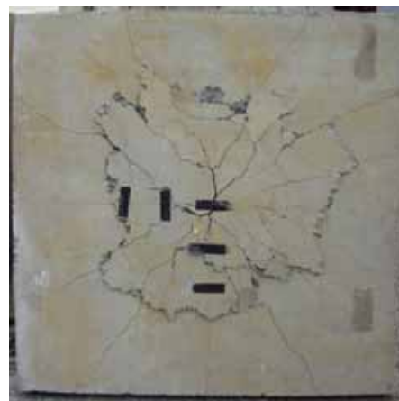
写真－1 床版引張側の破壊状況(20-1/2 A_s -1)
