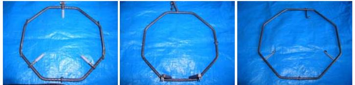
図-1 開孔補強筋図及び写真
