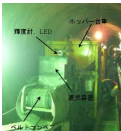
写真 - 1 現場での測定状況
