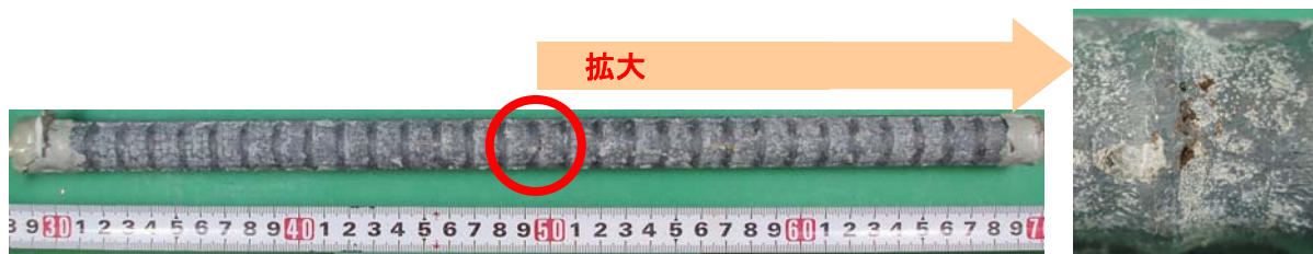
写真-2 腐食発生状況 (供試体 No. 45N-2)
