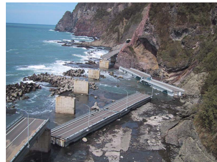
写真－2 旧大森大橋被災状況
