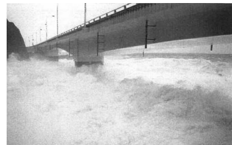
写真－1 旧大森大橋架橋環境
