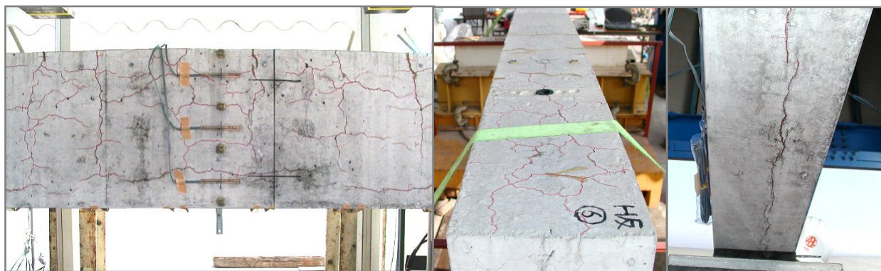
写真-2 H-A 試験体のひび割れ状況 (左：側面中央，中：上面，右：下面)
