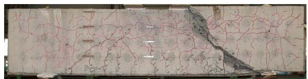
写真－5 No.4 試験体破壊状況
