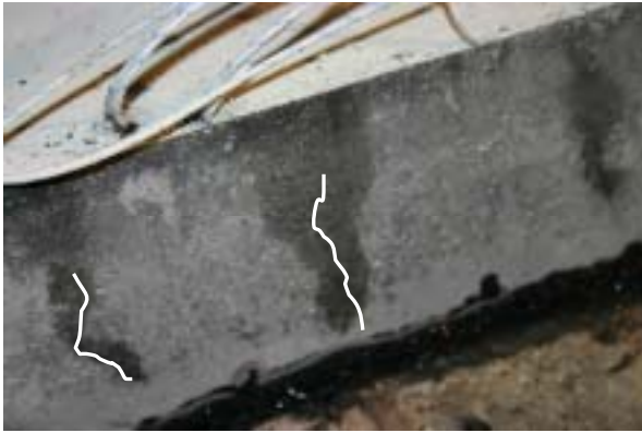
写真-2 水のしみ出し
