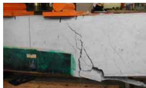
図-10 D-S-CFS1 供試体破壊状況
