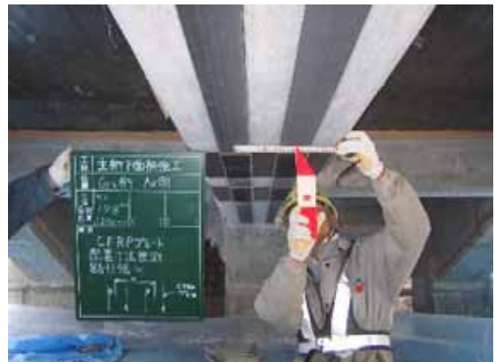
図-1 CFRP プレート接着工法適用例
