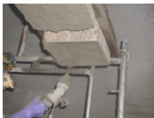
写真 - 1 吹付け状況 (t=10cm)
