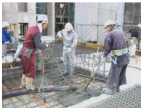
写真 - 4 再生粗骨材コンクリートの打設状況
